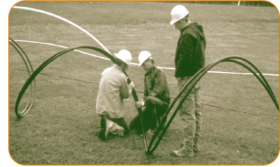
BOUCLE SOUTERRAINE DE TYPE « SLINKY »
