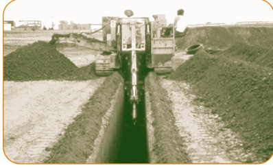
EXCAVATION D'UNE TRANCÉE POUR Y DÉPOSER DES BOUCLES SOUTERRAINES
